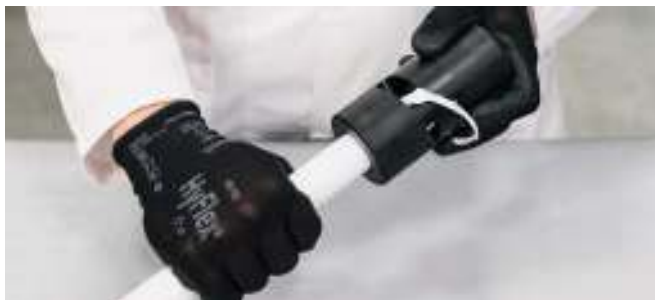
Рис. 29. Резка (труба steelPRES в изоляции из полипропилена).
